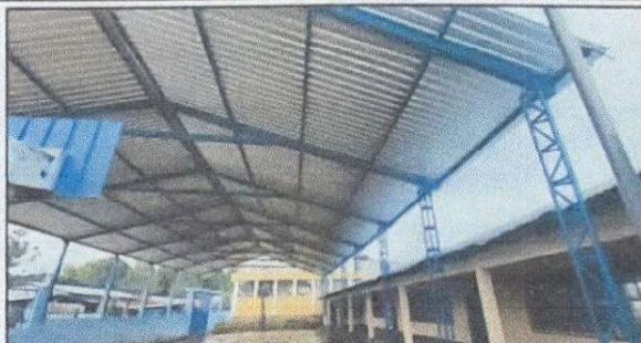
Foto 2: Area donde se realizó la instalación de estructura y reparación de techo
