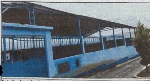
Foto 5: Area donde se realizó la instalación de estructura y reparación de techo
