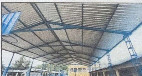
Foto 4: Area donde se realizó la instalación de estructura y reparación de techo
