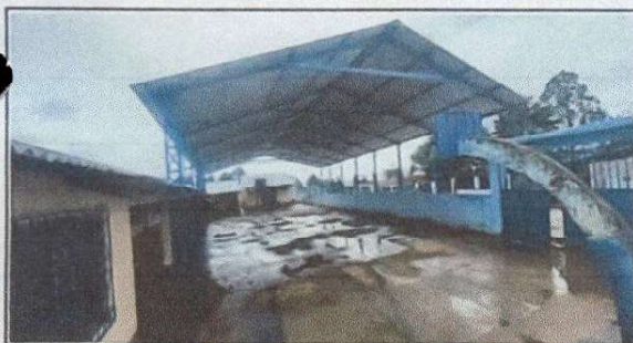
Foto 3: Area donde se realizó la instalación de estructura y reparación de techo
