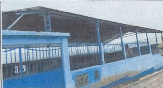
Foto 1: Area donde se realizó la instalación de estructura y reparación de techo
