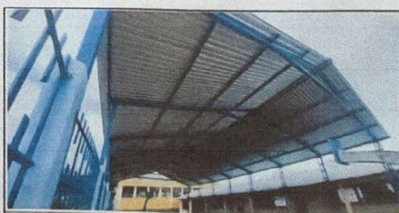
Foto 6: Area donde se realizó la instalación de estructura y reparación de techo
